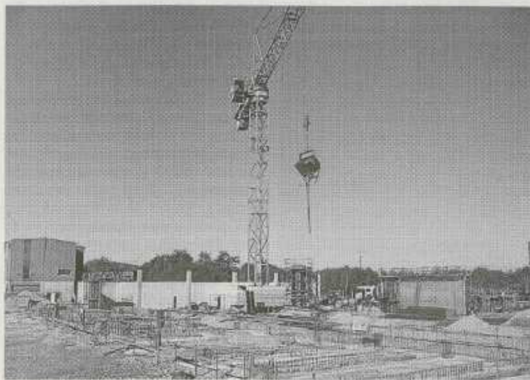
Le chantier de modernisation de l'usine de traitement des ordures ménagères a débuté le 4 juillet 2011 et s'achèvera fin 2012.
