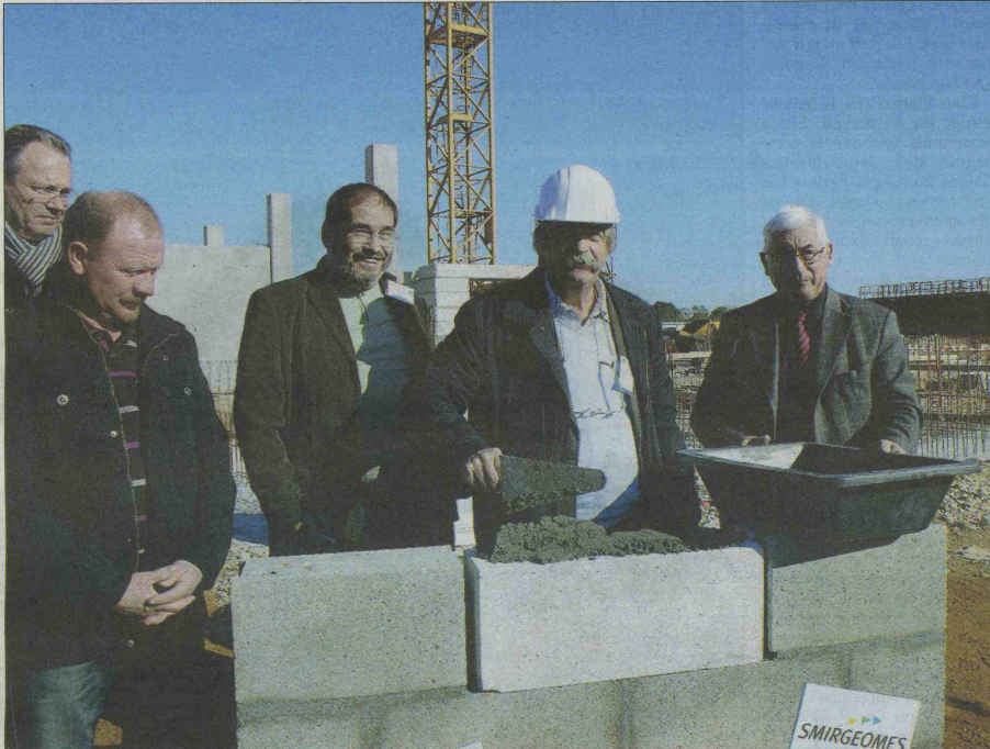
Gérard Clément (au centre) a posé vendredi la première pierre du chantier de modernisation de l'usine du Smirgeomes en présence de nombreux élus dont Michel Letellier, maire de Saint-Calais. La mise en service est prévue pour septembre 2012.
